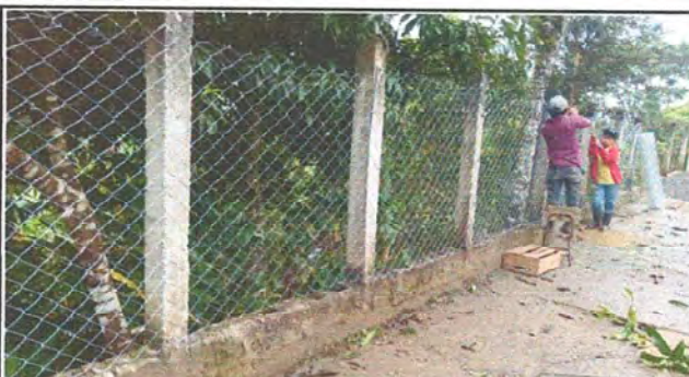
Foto 3: reparacion del cerco o muro perimetral del establecimiento.
