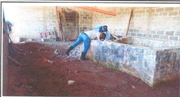
Foto 1: se destruyo la pila para poder ponerle piso y utilizar el espacio para aula.
