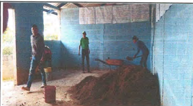
Foto 4: avance de la puesta del entortado de cemento en el modulo 1
