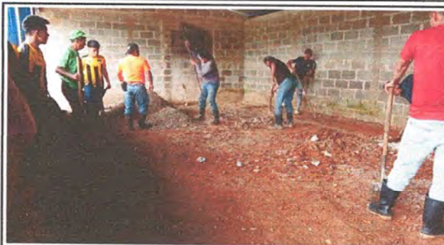
Foto 2: avance de aplanado de piso para luego ponerle torta de concreto.
